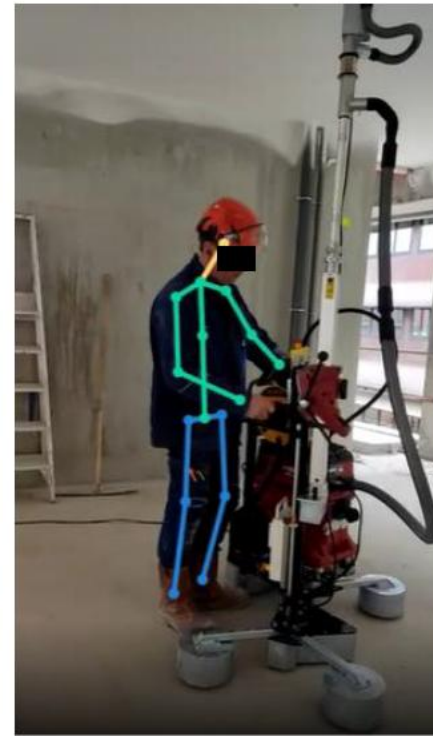
Méthode avec outil - perçage au plafond
